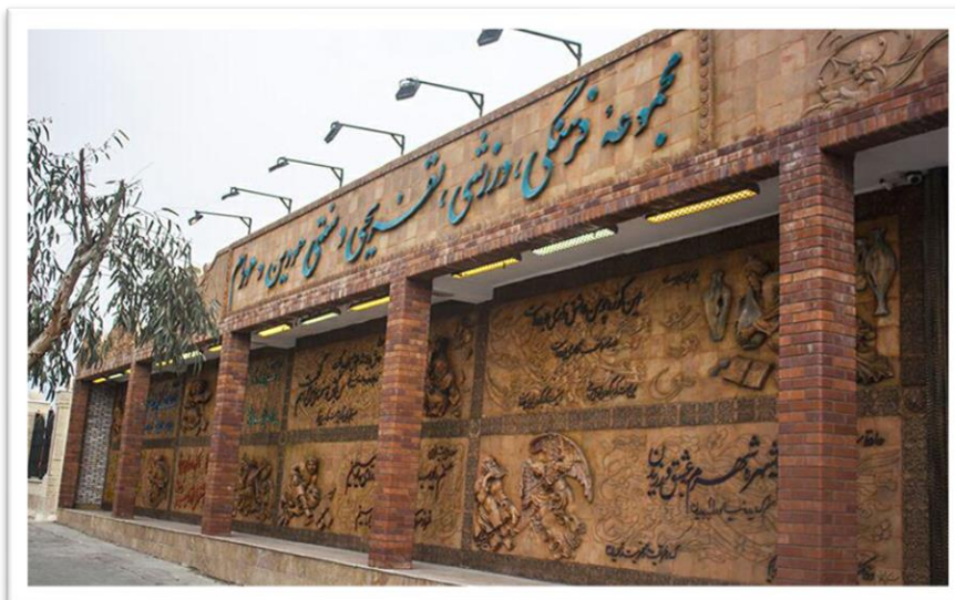
۱۰. طراحی و اجرای سیستم نورپردازی، سیستم صوتی ، سیستم سرمایش و گرمایش و سیستم هوشمند
