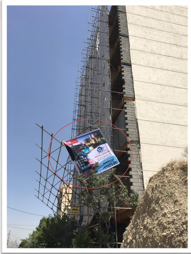
۴۲. طراحی و اجرای هوشمند سازی ساختمان مسکونی ۱۲ واحدی آقای هاشمی - اختیاریه جنوبی
