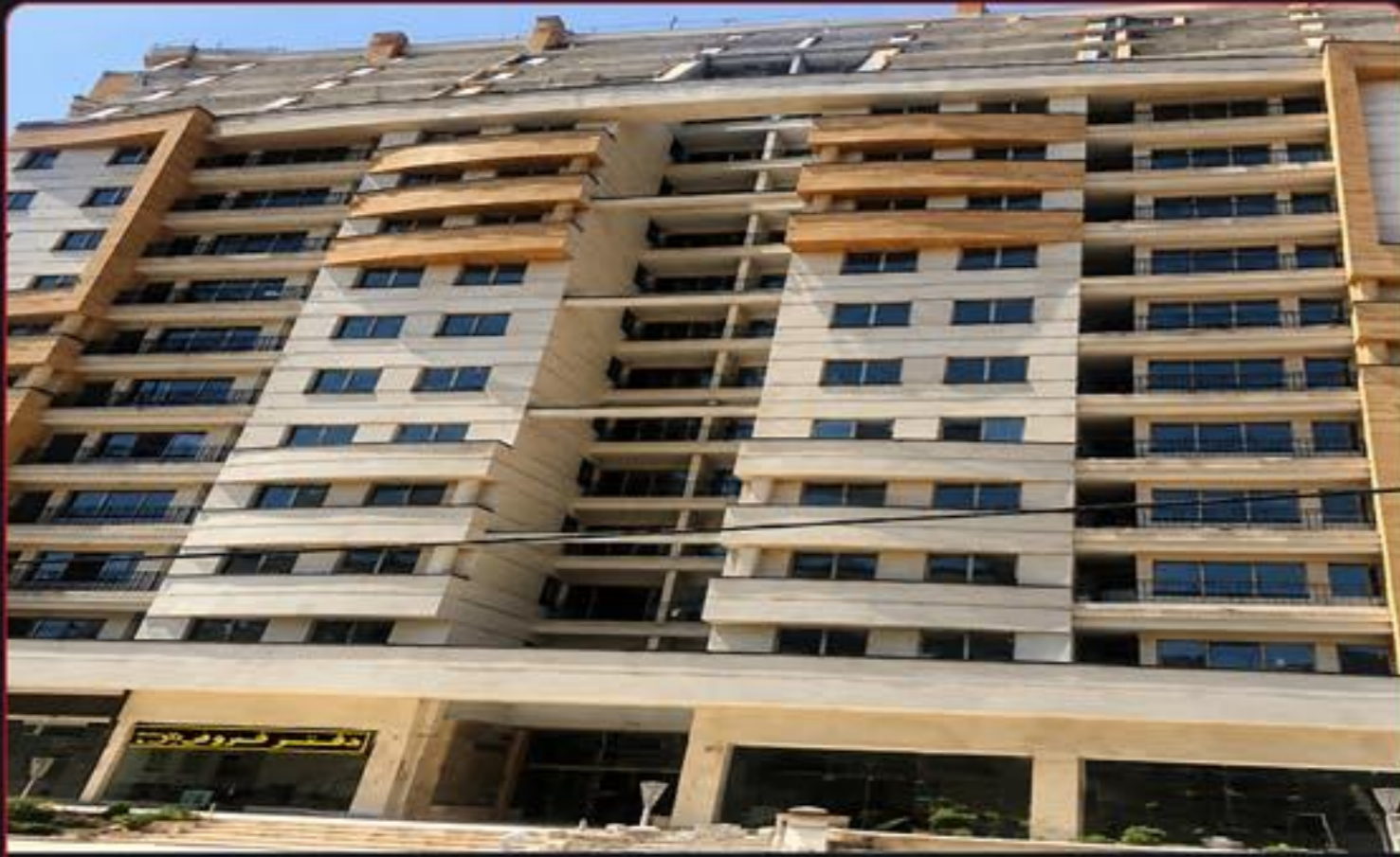
۳۳- پروژه هوشمندسازی برج مسکونی ۱۲ واحدی - کالج - بلوار ارتش کارفرما : آقای مهندس قوپرانلو
