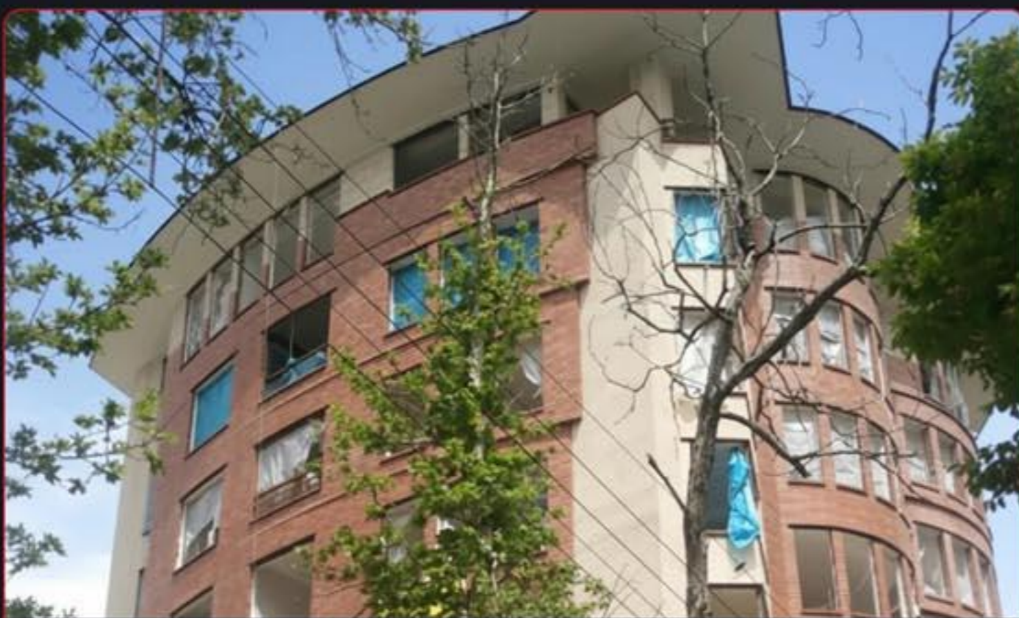
۱۱- پروژه هوشمندسازی برج مسکونی ۲۶ واحدی - الهیه ، خیابان بوسنی و هرزه گوین کارفرما : آقای فرح بخش
