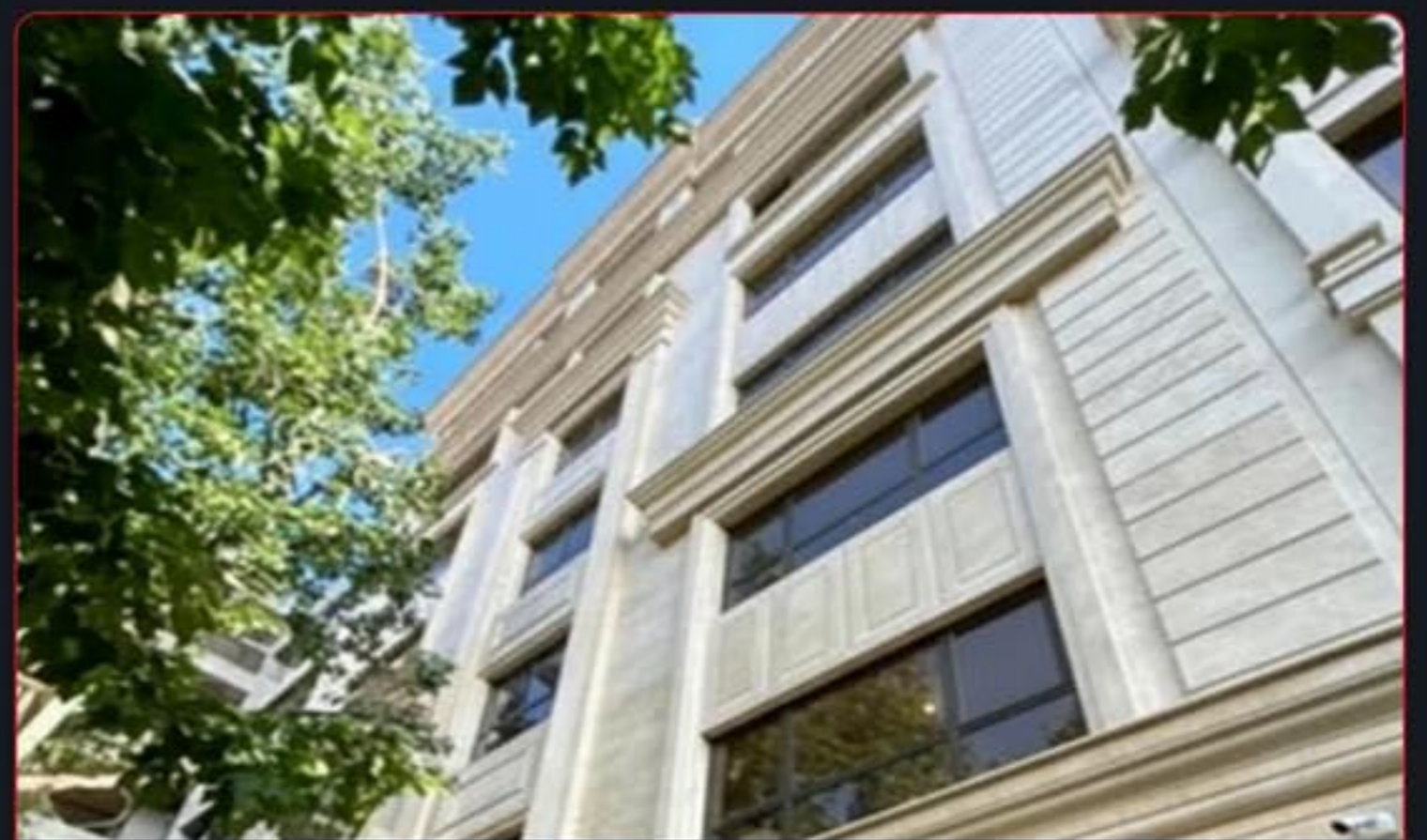
۱۲- پروژه هوشمند سازی ساختمان مسکونی ۱۲ واحدی سنبل کارفرما : جناب آقای افضل
