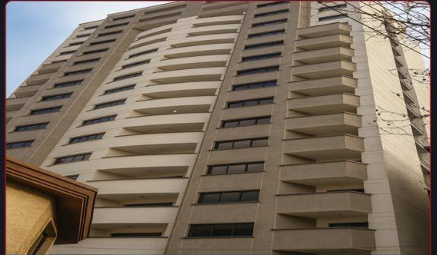
۶- پروژه هوشمند سازی برج مسکونی پزشکان زنبق زعفرانیه ۶۰ واحدی کارفرما : جناب آقای محمدی
