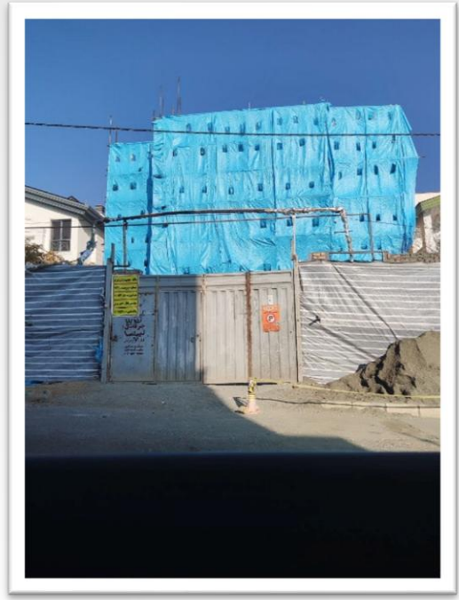
۳۰. طراحی و اجرای هوشمند سازی ویلاي فورلكس باستي هیلز لواسان كارفرما : جناب آقای سراج
