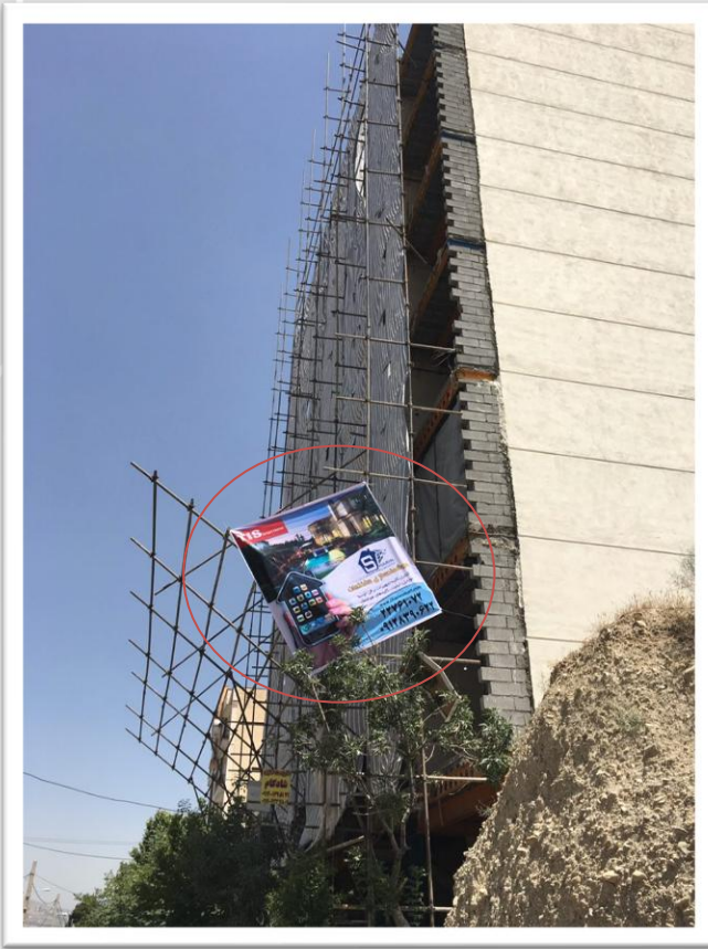
۷۱. طراحی و اجرای هوشمند سازی ساختمان مسکونی ۱۲ واحدی آقای هاشمی - اختیاریه جنوبی
