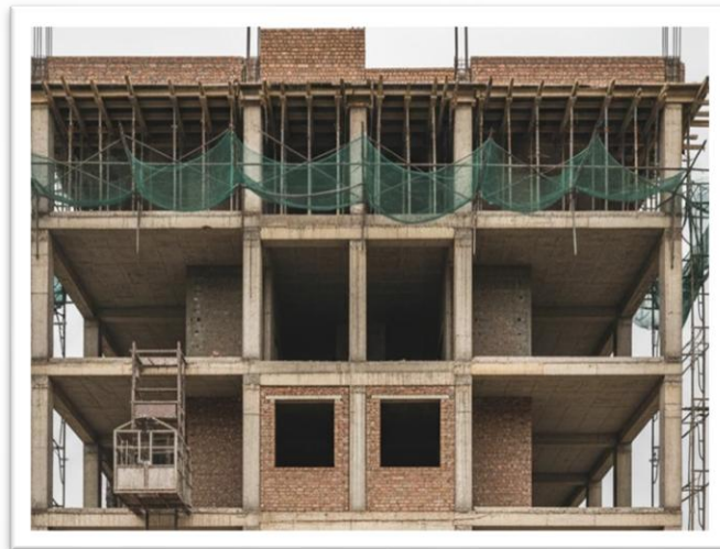
۲۷. طراحی و اجرای هوشمند سازی ساختمان اداری ۱۲ واحدی هوپزه شرکت ایلیا مهام مهررادین
