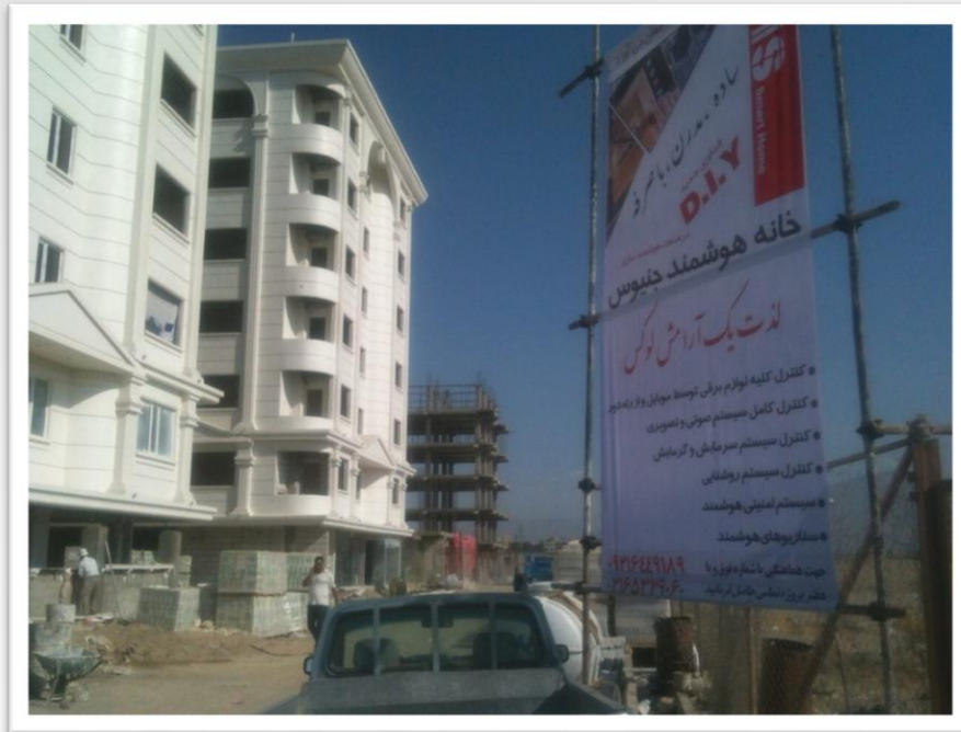
۵۹. طراحی و اجرای هوشمند سازی مجتمع مسکونی ۸۴ واحدی آریو - شهریار
