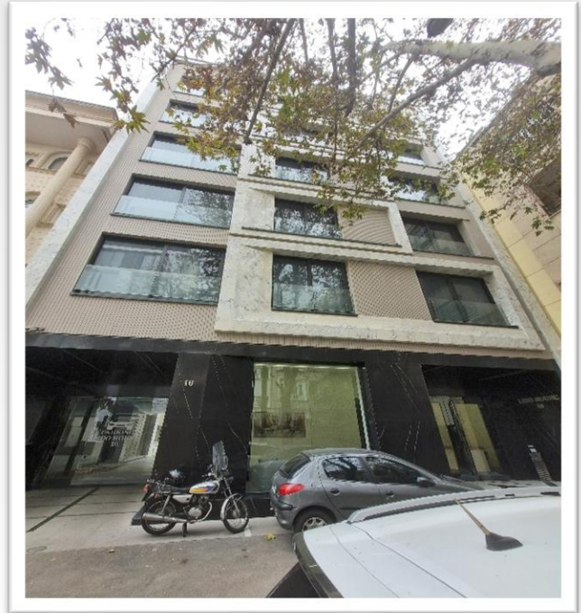
۱۱. طراحی و اجرای هوشمند سازی ساختمان مسکونی ۶ واحدی دیباجی کارفرما: جناب آقای جواد میزان
