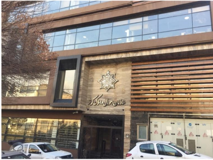
۷۷. طراحی و اجرای هوشمند سازی ساختمان اداری اموال و املاک کوثر خیابان هفدهم گاندی
