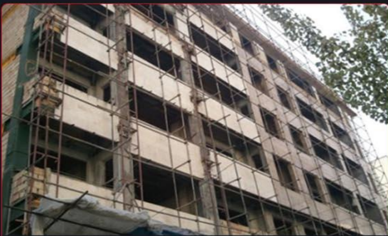
۳۱- پروژه هوشمندسازی ساختمان مسکونی ۴۰ واحدی سایپا - آرم گروه پارسیان خیابان ۲۱ ولنجک کارفرما : —
