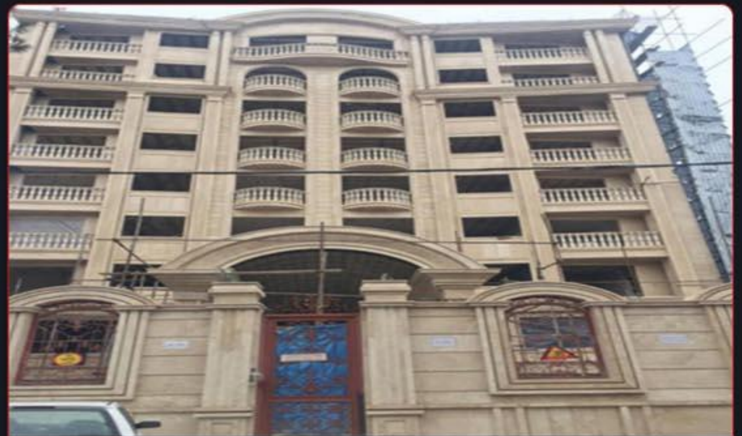
۳۶- پروژه هوشمند سازی مجتمع مسکونی ۲۶ واحدی تجریش کارفرما : آقای قلی پور
