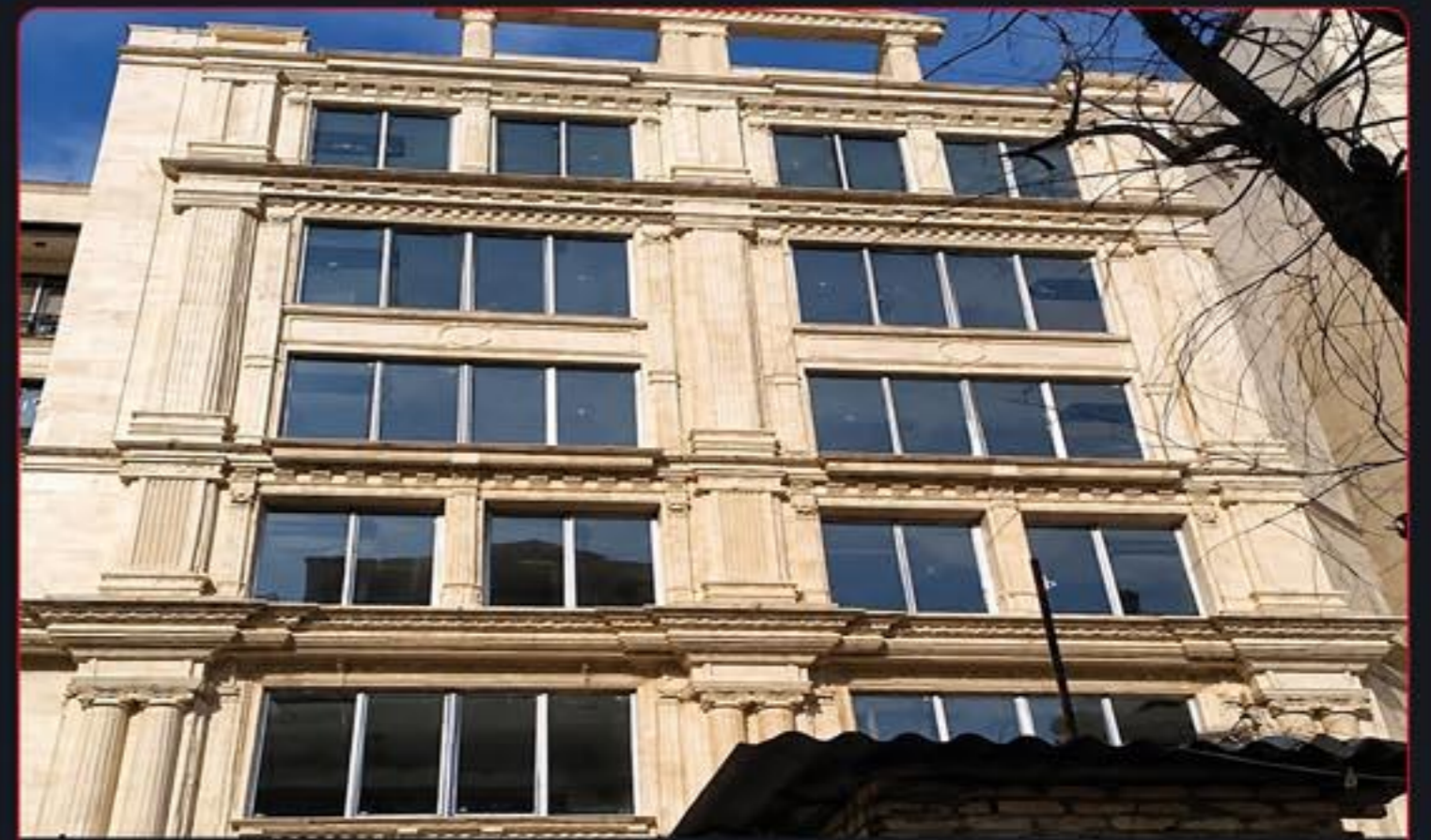
۲۴- پروژه هوشمندسازی برج مسکونی ۲۱ ولنجک کارفرما : جناب آقای قربانی
