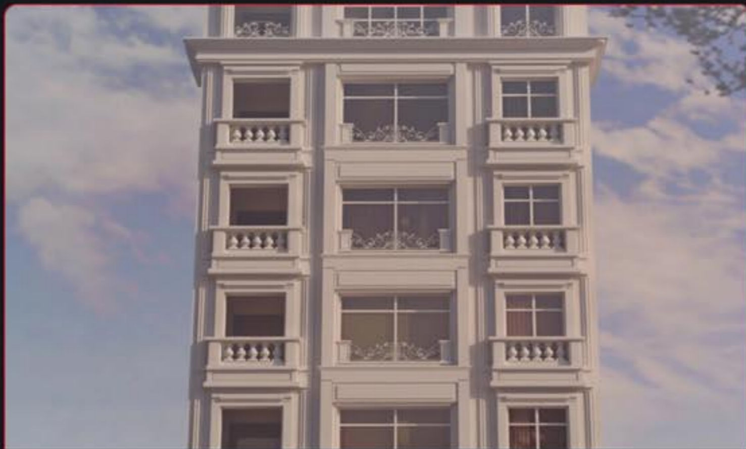
۲۷- پروژه هوشمندسازی برج مسکونی ولنجک کارفرما : جناب آقای مهندس فراهانی
