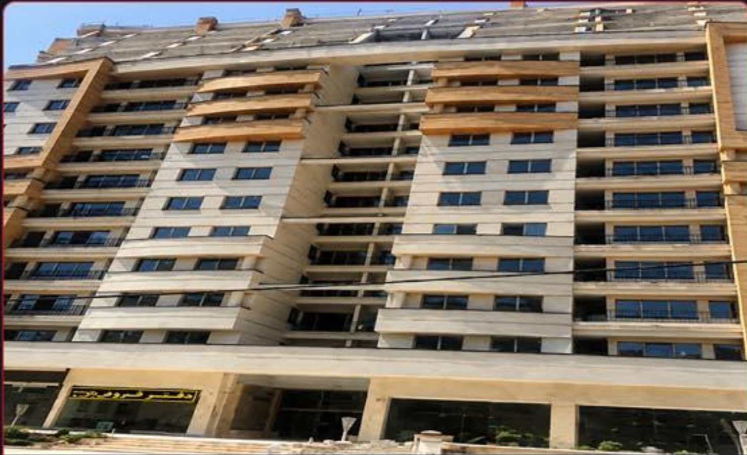
۳۳- پروژه هوشمندسازی برج مسکونی ۱۲ واحدی - کالج - بلوار ارتش کارفرما : آقای مهندس قوپرانلو
