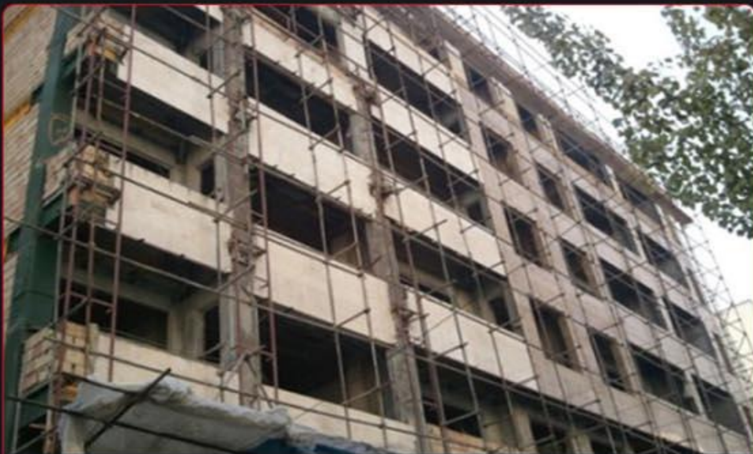
۳۱- پروژه هوشمندسازی ساختمان مسکونی ۴۰ واحدی آرم گروه پارسیان خیابان ۲۱ ولنجک کارفرما : سایپا
