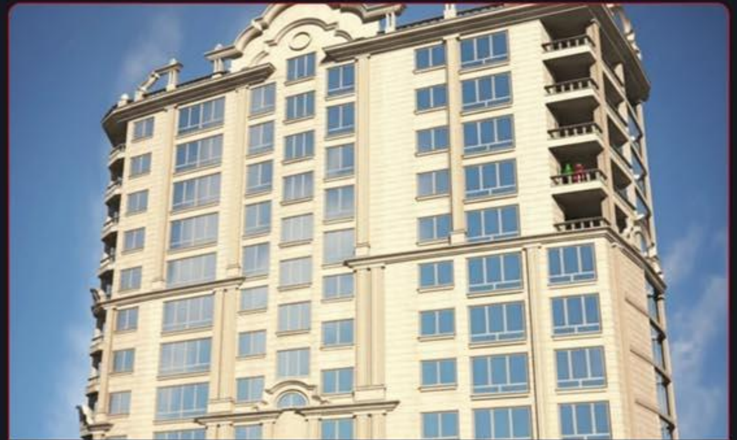
۳۰- پروژه هوشمندسازی برج مسکونی مژده - تجریش کارفرما : دکتر غریلو
