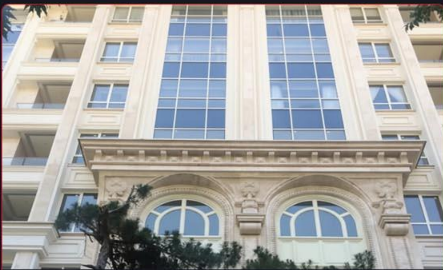
۱۹- پروژه هوشمندسازی برج مسکونی ۵۲ واحدی بهار زعفرانیه خیابان فلاحی، خیابان بهار کارفرما : جناب آقایان جهانیان و زرکش
