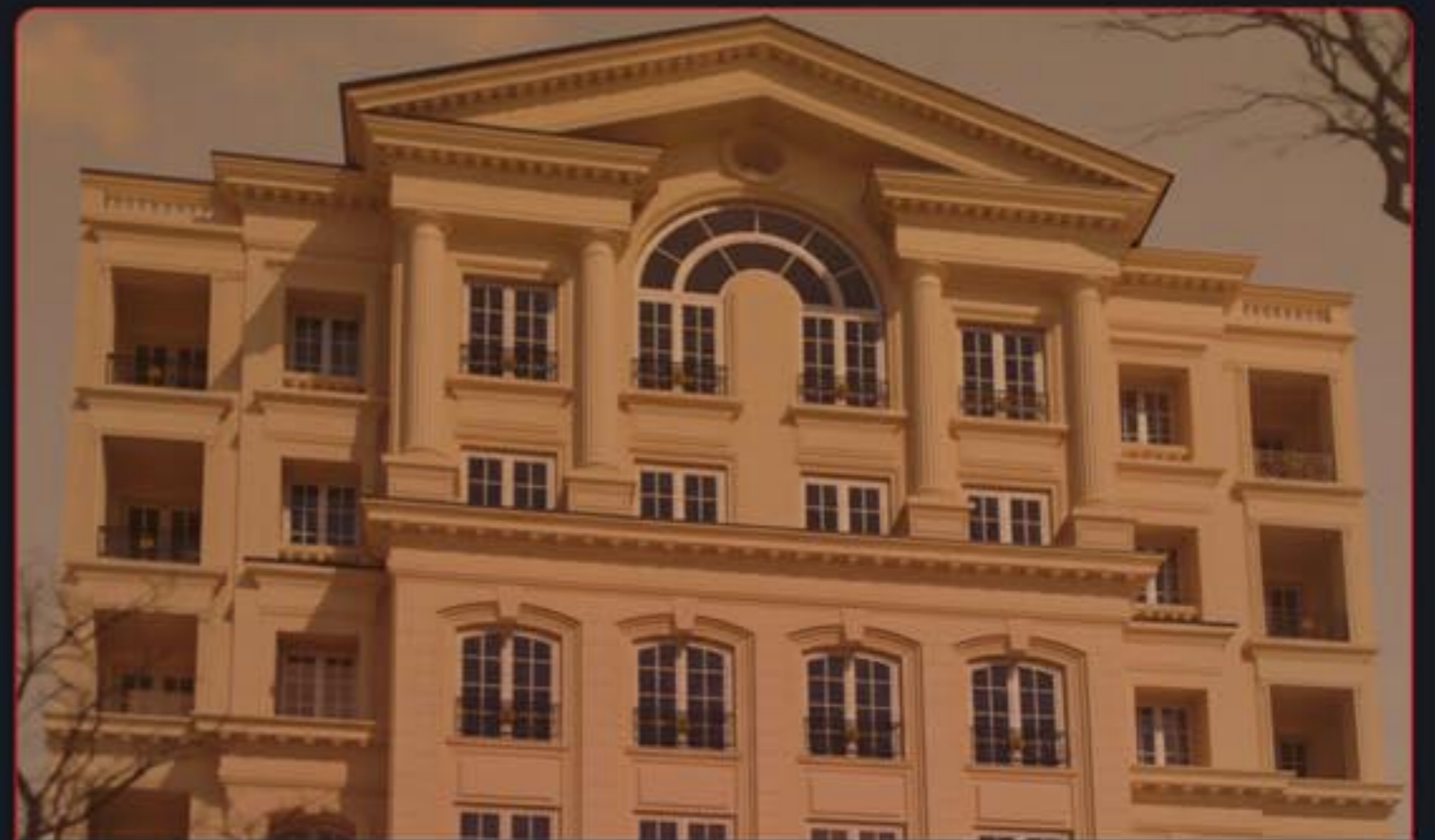
۲۸- پروژه هوشمندسازی برج مسکونی نیاوران کارفرما : جناب آقای نادری
