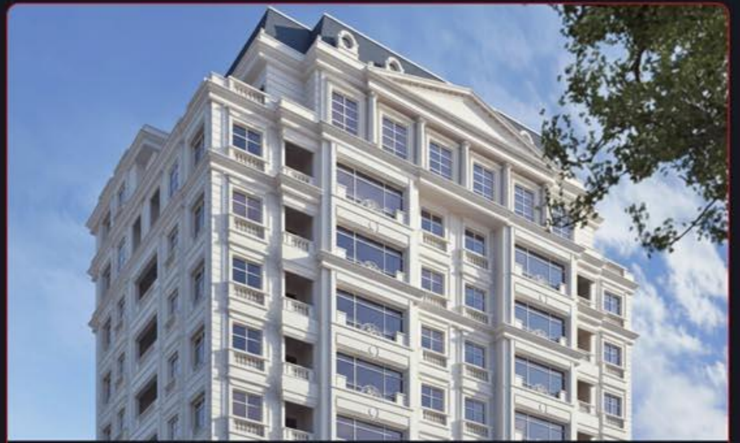
۱۸- پروژه هوشمندسازی برج مسکونی ۱۹ واحدی - فرمانیه بالاتر از سفارت کارفرما : جناب آقایان گتمیری و تفرشی
